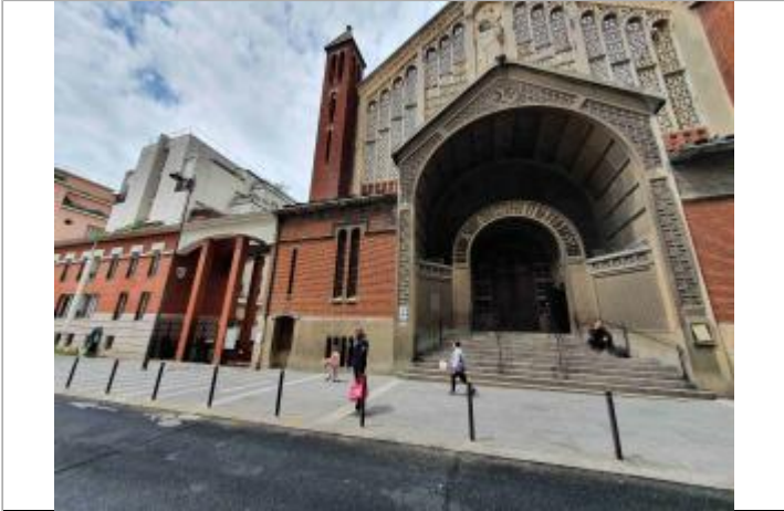
Escalier d'accès à l'Eglise
