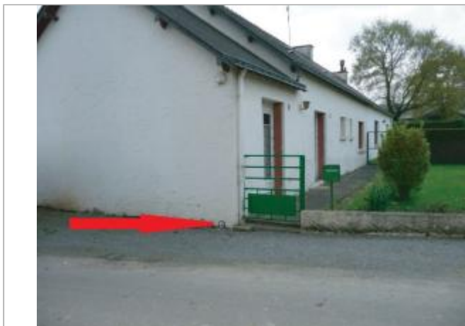
Maison d'habitation lieu-dit "Les Rivières" à Guéméné-Penfao
