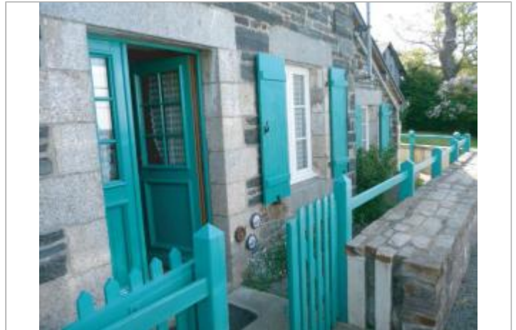
Maison éclésièrre de Mons à Bruz
