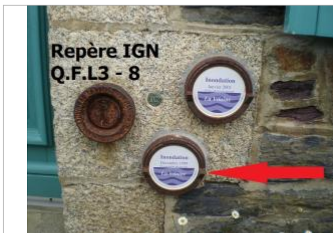
Repère normalisé de l'inondation du 29 décembre 1999
