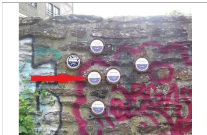
Repère normalisé de l'inondation du 24 octobre 1966
