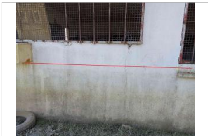
Vue du repère - Photo © AGERIN
