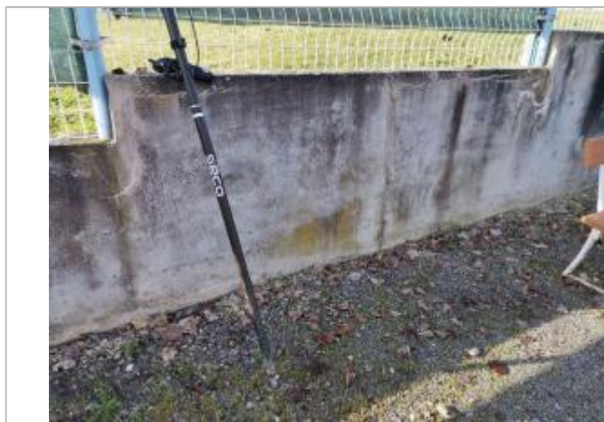
Vue du repère - Photo © AGERIN
