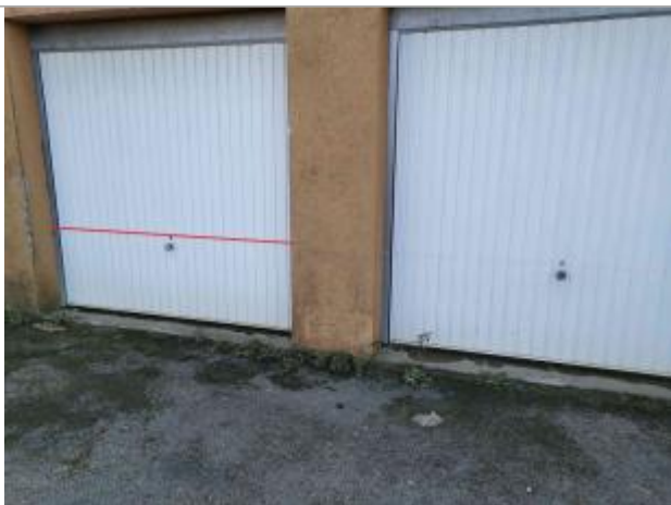
Vue du repère - Photo © AGERIN
