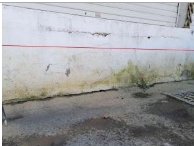
Vue du repère - Photo © AGERIN
