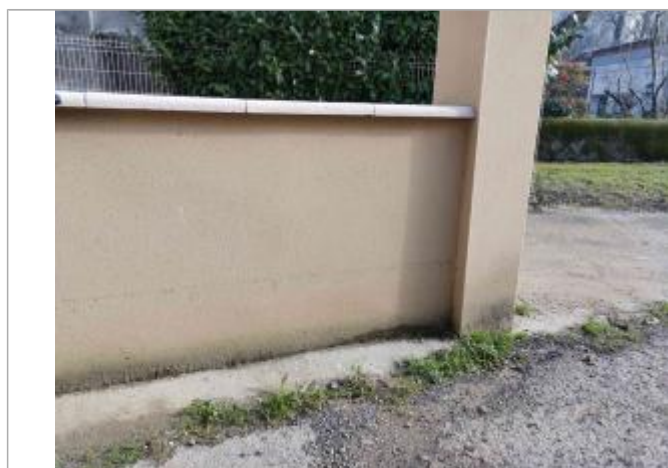
Vue du repère - Photo © AGERIN
