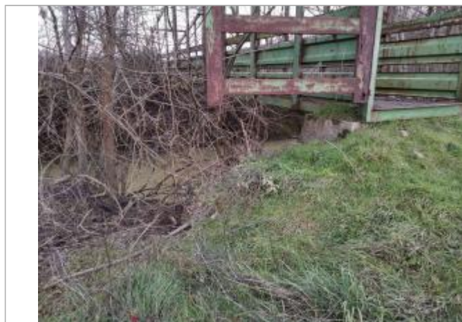
Vue du repère - Photo © AGERIN
