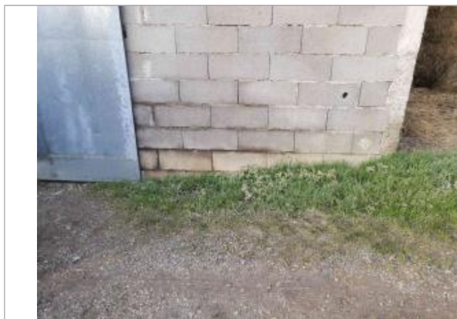
Vue du repère - Photo © AGERIN
