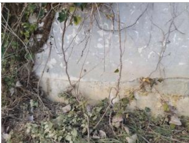
Vue du repère - Photo © AGERIN
