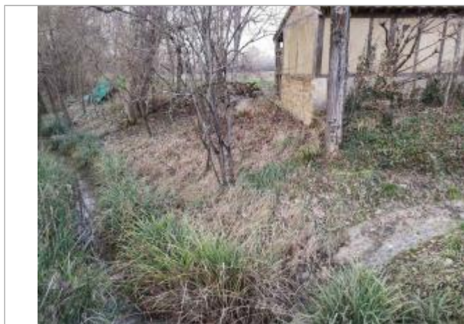
Vue du repère - Photo © AGERIN
