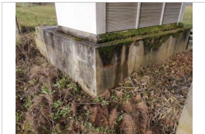
Vue du repère - Photo © AGERIN
