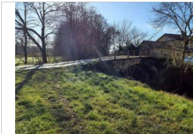
Vue du site - Photo © AGERIN
