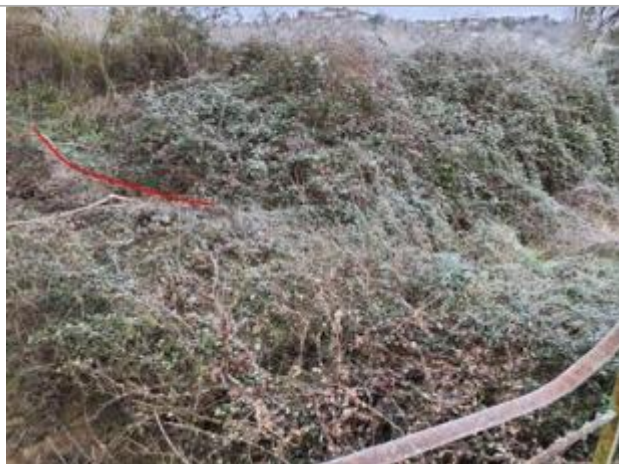
Vue du repère - Photo © AGERIN
