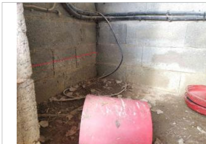
Vue du repère - Photo © AGERIN
