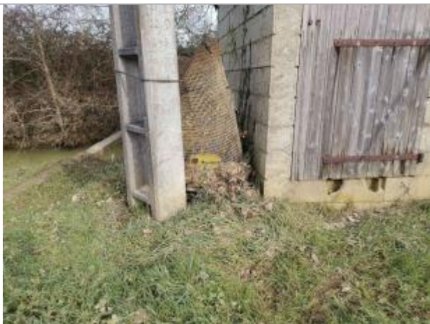
Vue du repère - Photo © AGERIN
