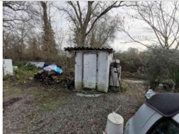
Vue du site - Photo © AGERIN
