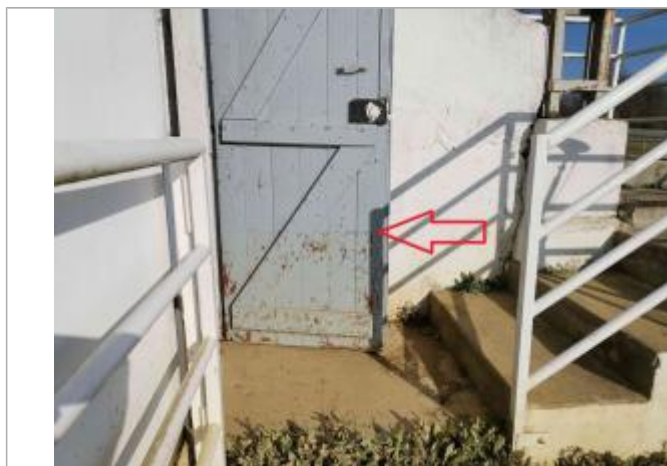
Vue du repère - Photo © AGERIN
