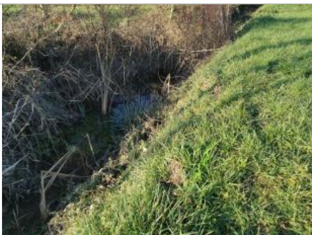
Vue du repère - Photo © AGERIN
