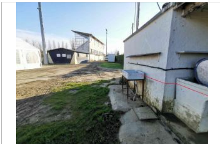
Vue du site - Photo © AGERIN
