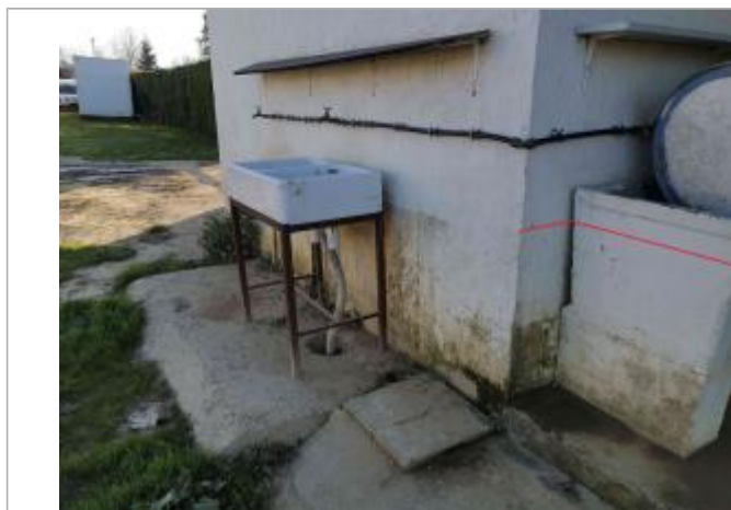
Vue du repère - Photo © AGERIN
