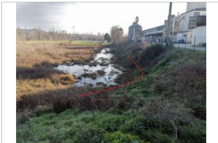
Vue du site - Photo © AGERIN
