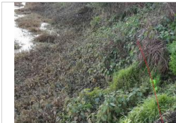
Vue du repère - Photo © AGERIN
