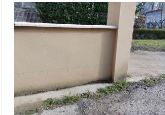
Vue du repère - Photo © AGERIN
