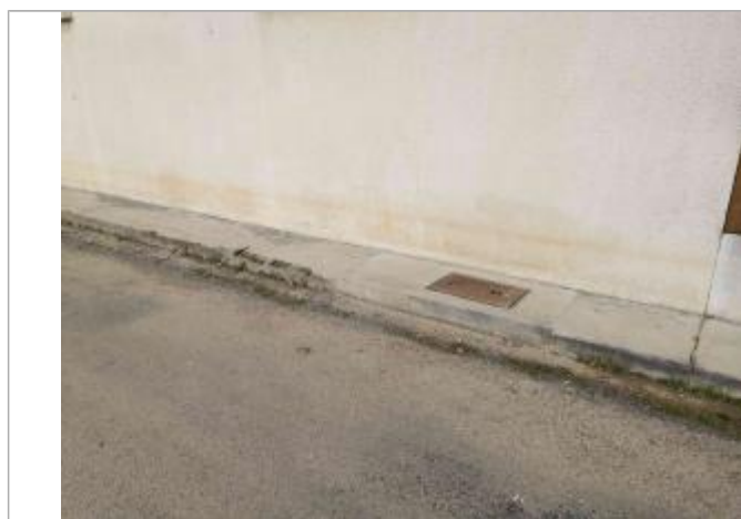
Vue du repère - Photo © AGERIN
