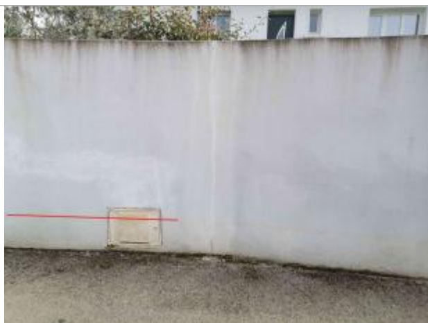
Vue du repère - Photo © AGERIN
