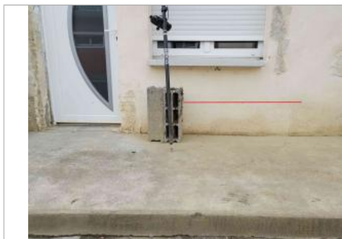
Vue du repère - Photo © AGERIN
