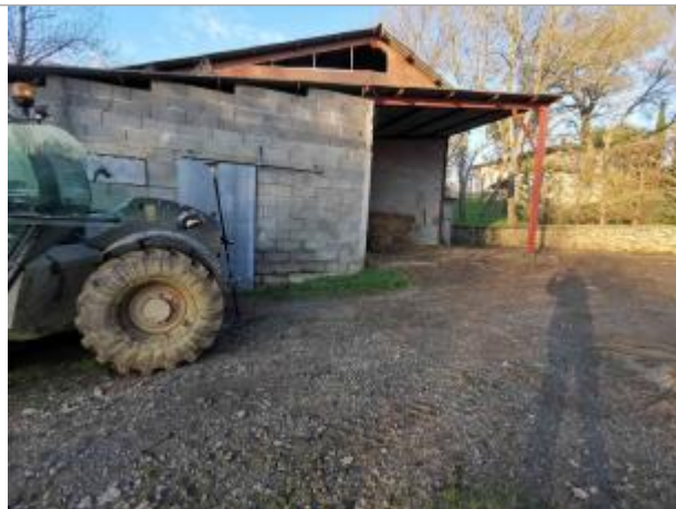
Vue du site - Photo © AGERIN
