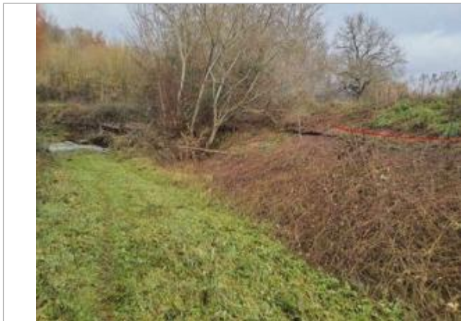
Vue du site - Photo © AGERIN
