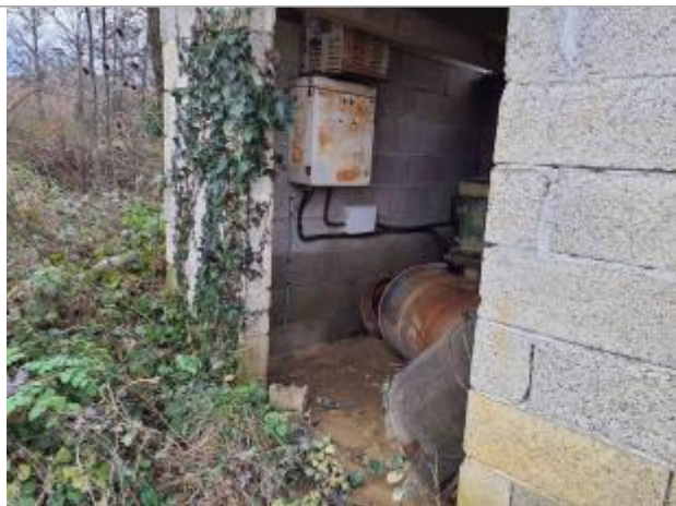
Vue du repère - Photo © AGERIN
