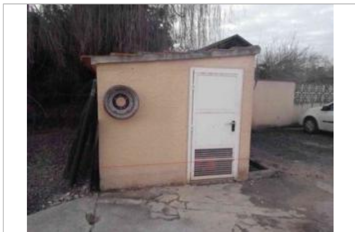
Vue du repère - Photo © AGERIN
