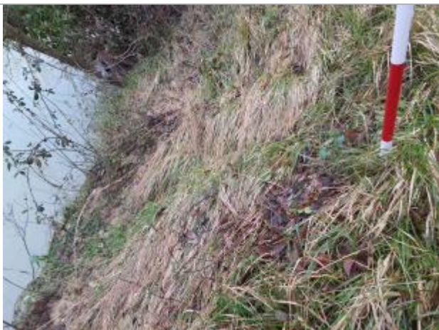
Vue du repère - Photo © AGERIN
