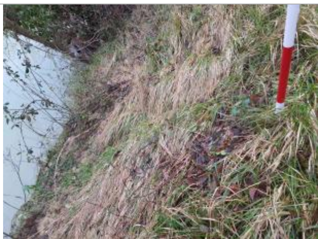
Vue du repère - Photo © AGERIN
