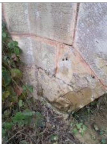
Vue du repère - Photo © AGERIN
