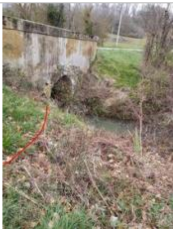
Vue du repère - Photo © AGERIN
