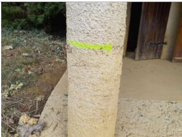
Vue du repère - Photo © AGERIN
