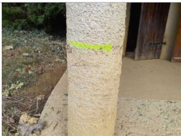
Vue du repère - Photo © AGERIN
