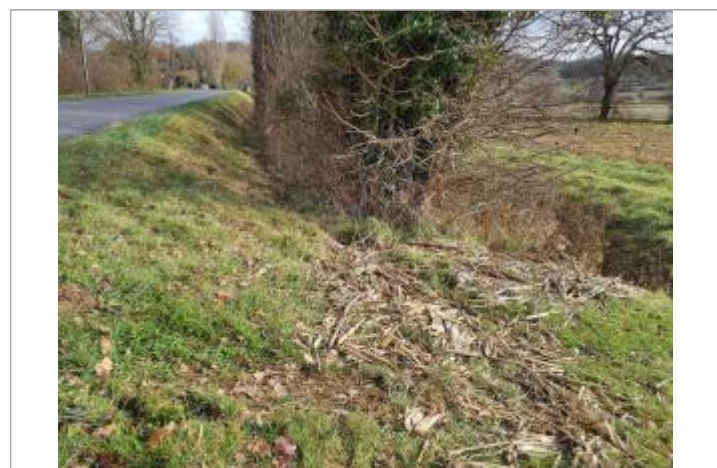
Vue du repère - Photo © AGERIN
