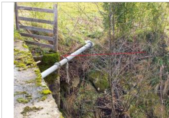
Vue du repère - Photo © AGERIN
