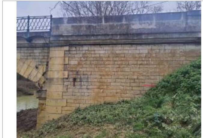
Vue du site - Photo © AGERIN
