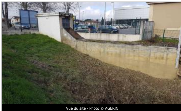
Vue du site - Photo © AGERIN
