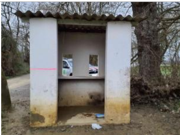
Vue du repère - Photo © AGERIN
