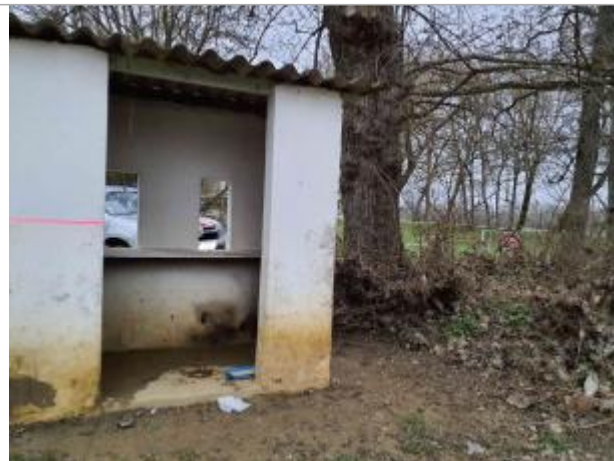
Vue du site - Photo © AGERIN
