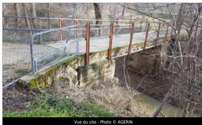
Vue du site - Photo © AGERIN
