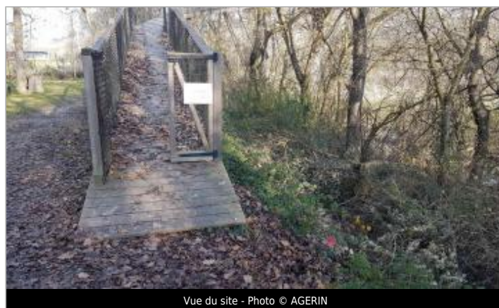
Vue du site - Photo © AGERIN
