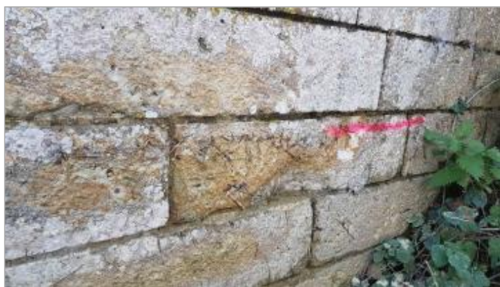
Vue du repère - Photo © AGERIN
