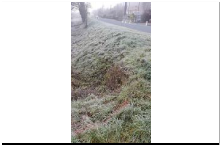
Vue du repère - Photo © AGERIN
