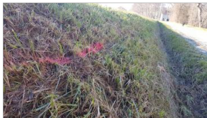
Vue du repère - Photo © AGERIN
