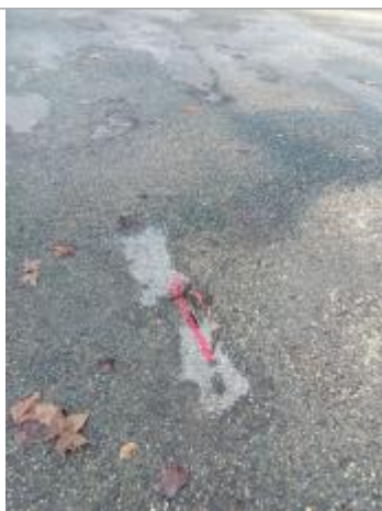
Vue du repère - Photo © AGERIN
