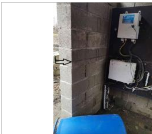
Vue du repère - Photo © AGERIN
