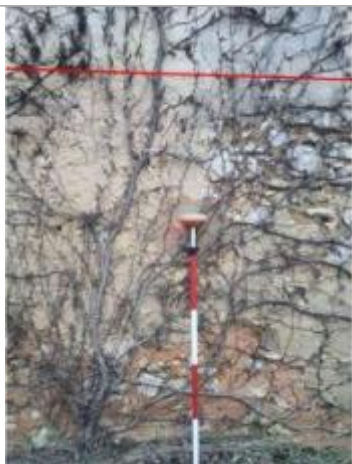
Vue du repère - Photo © AGERIN
