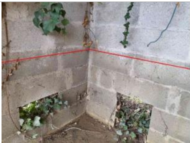
Vue du repère - Photo © AGERIN
